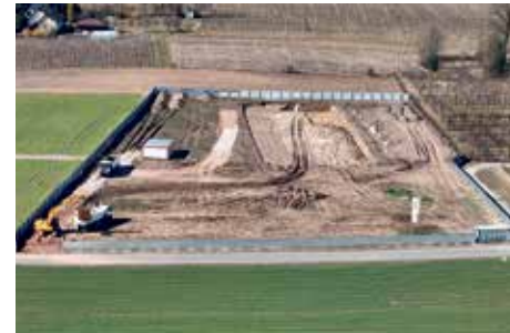
Rozpoczęto budowę budynków mieszkalnych w ramach SIM
