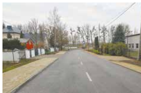
Przebudowa ul. Kolejowej na finiszu
