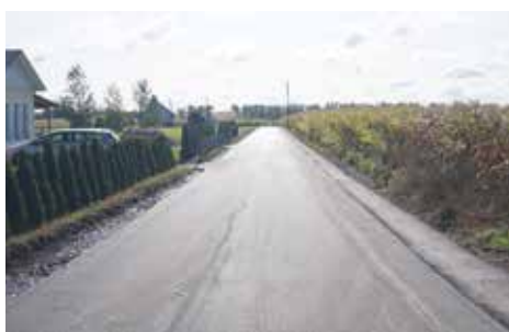
Przebudowaliśmy drogę w Steklinku
