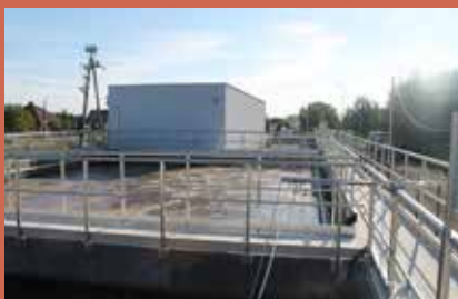
Rozbudowa oczyszczalni ścieków zakończona str. 3
