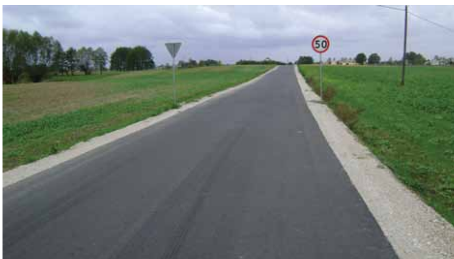
Droga w Ograszce przebudowana z wykorzystaniem środków NPPDL
