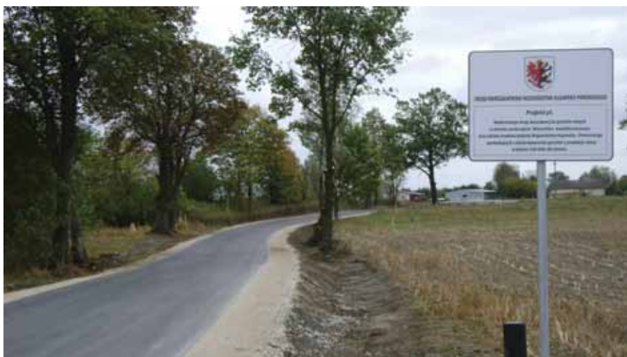
Droga w Makowiskach przebudowana z wykorzystaniem środków FOGR
