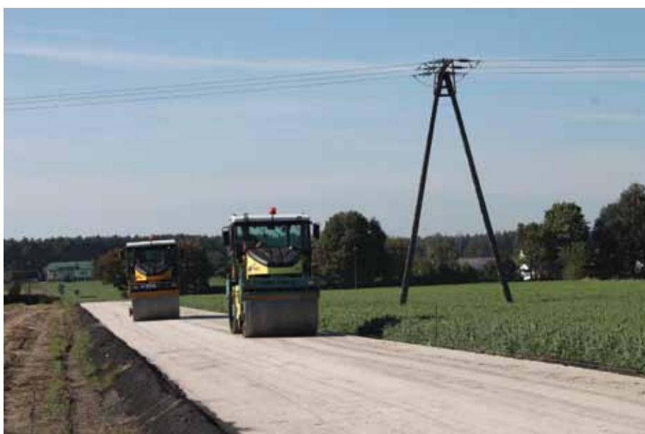
Prace w zakresie przebudowy drogi w Czernikówku z wykorzystaniem środków FOGR
