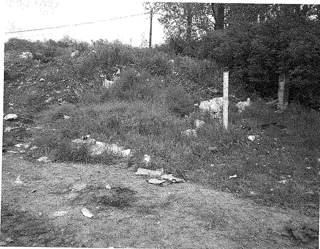
Zdjęcie nr 4. Zbiornik na odcieki
