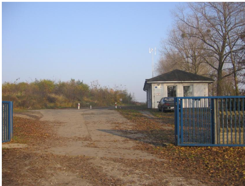
Rysunek 38 Gminne składowisko odpadów komunalnych w Jackowie
