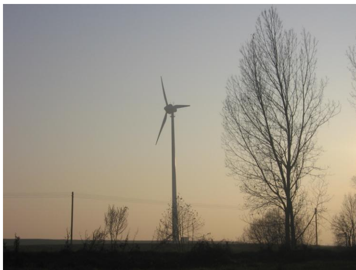
Rysunek 35 Elektrownia wiatrowa w miejscowości Liciszewy
