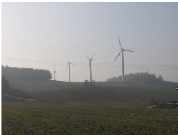
Rysunek 36 Elektrownie wiatrowe w miejscowości Witoważ
