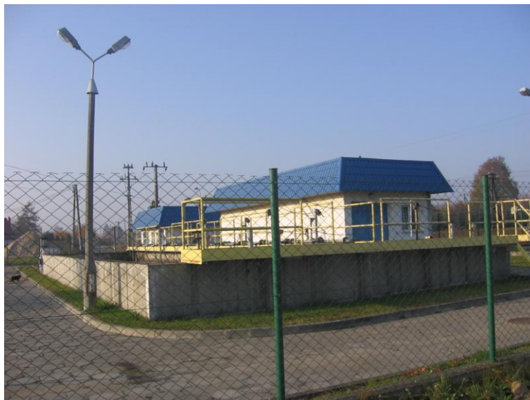
Rysunek 30 Gminna oczyszczalnia ścieków w miejscowości Czernikowo
